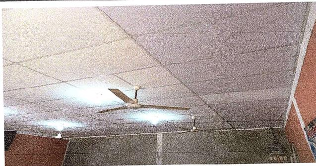
FOTO 17: Colocación de cielo falso.
