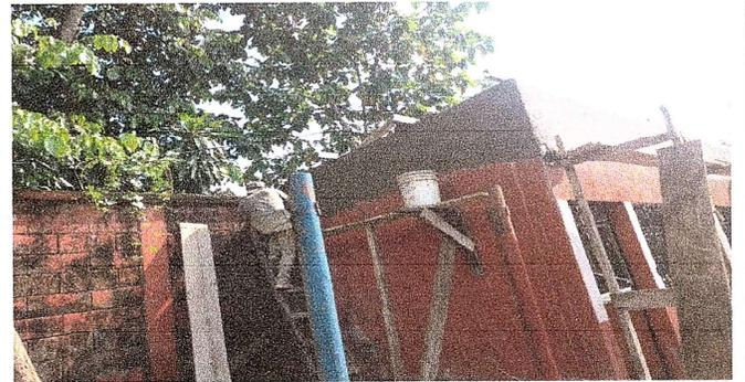
FOTO 8: Repello de muro de cocina
