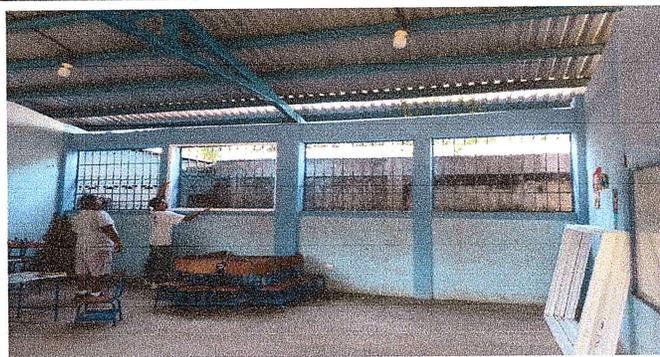
FOTO 15: Se observa la puesta de ventanas pvc.
