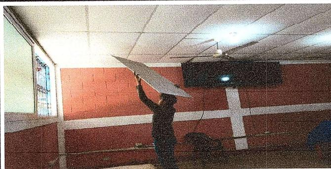
FOTO 17: Se observa el arreglo del cielo falso.
