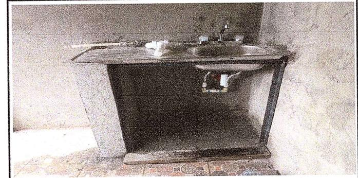
FOTO 6: Sustitución de lavatrastos de cemento en mal estado por lavamano de metal.
