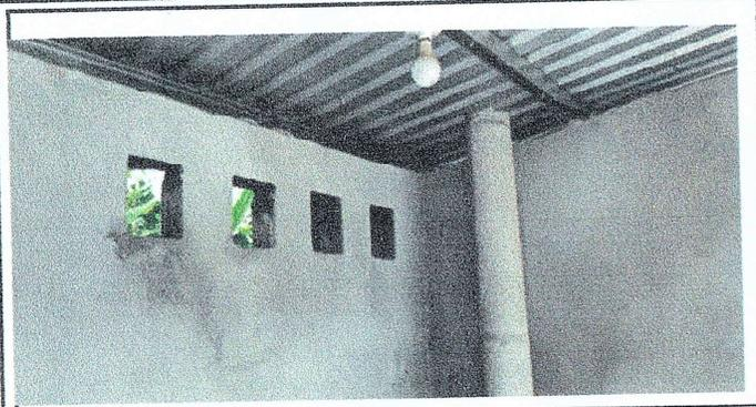
FOTO 1: Se observa el tubo de concreto en deterioro
