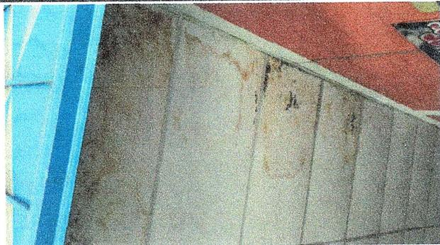
FOTO 17: Se observa el deterioro del cielo falso, urge sustitucion.
