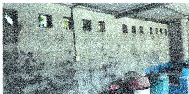
FOTO 8: Se observa el estado de muro , se necesita repello
