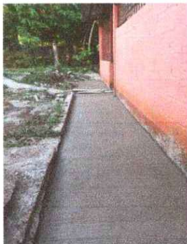
Foto 3: Se observa el proceso de conformacion de banquetas
