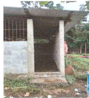
Foto 6: Se observa el proceso de sustitución de puerta de metal
