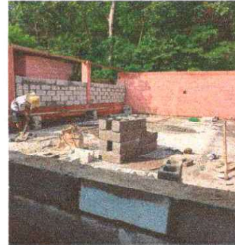
Foto 2: Se observa la conformación del muro perimetral.
