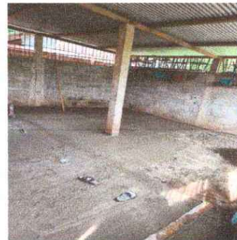
Foto 4: Se observa que el piso esta siendo colocado.
