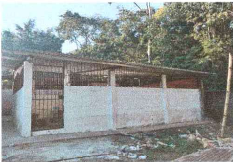
Foto 5: Se observa conformacion de banquetas y muro perimetral
