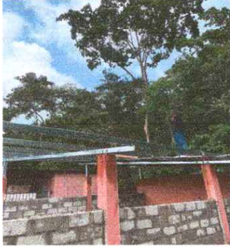
Foto 1: Se observa el proceso de cambio de tendales de madera por estructura metalica.
