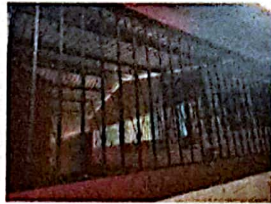
Foto 4: FOTOGRAFIA SUMISTRO E INSTALACION DE BALCONES
