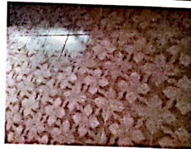
Foto 12: FOTOGRAFIA SUMINISTRO E INSTALACION DE PISO EN PASILLO
