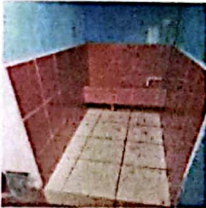
Foto 3: FOTOGRAFIA SUMISTRO E INSTALACION DE AZULEJO
