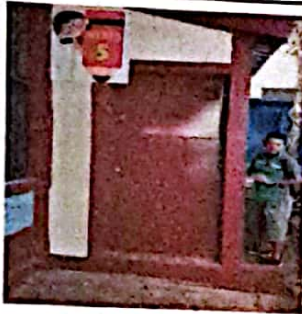
Foto 9: FOTOGRAFIA SUMINISTRO E INSTALACION DE PUERTA CON CHAPA
