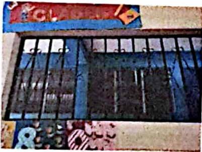
Foto 11: FOTOGRAFIA SUMINISTRO E INSTALACION DE BALCONES
