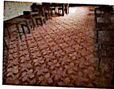
Foto 10: FOTOGRAFIA SUMINISTRO E INSTALACION DE PISO EN AULA
