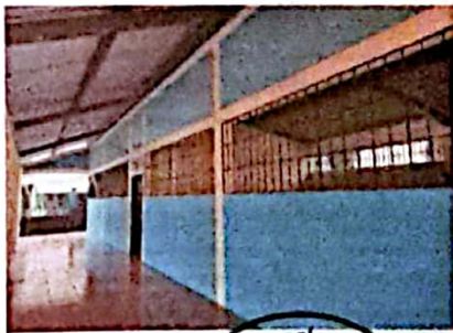
Foto 5: FOTOGRAFIA SUMINISTRO E INSTALACIÓN DE PISO EN EL PASILLO, APLICACIÓN DE PINTURA EN EL EXTERIOR DEL AULA
