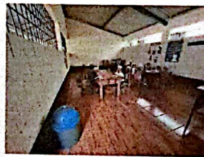
Foto 10: FOTOGRAFIA SUMINISTRO E INSTALACION DE PISO EN EL AULA, PINTURA EN EL INTERIOR DEL AULA
