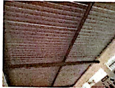
Foto 8: FOTOGRAFIA SUMINISTRO E INSTALACION ESTRUCTURA PORTANTE DE METAL, LAMINA TROQUELADA
