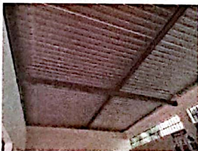
Foto 11: FOTOGRAFIA SUMINISTRO E INSTALACION ESTRUCTURA PORTANTE DE METAL, LAMINA TROQUELADA
