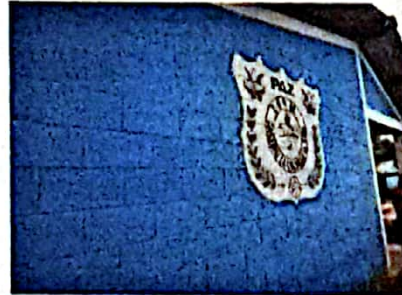
Foto 4: FOTOGRAFIA SUMINISTRO Y APLICACIÓN DE PINTURA EN EL EXTERIOR DEL AULA
