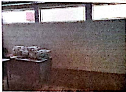
Foto 3: FOTOGRAFIA SUMINISTRO Y APLICACIÓN DE PINTURA EN EL INTERIOR DEL AULA
