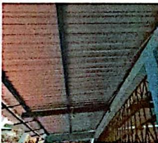
Foto 5: FOTOGRAFIA SUMINISTRO E INSTALACION ESTRUCTURA PORTANTE DE METAL, LAMINA TROQUELADA
