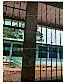
Foto 6: FOTOGRAFIA SUMINISTRO E INSTALACION DE BALCONES
