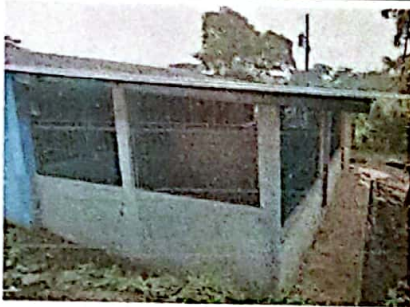
Foto 3: FOTOGRAFIA MEJORAMIENTO MURO DEL AULA, BALCONES
