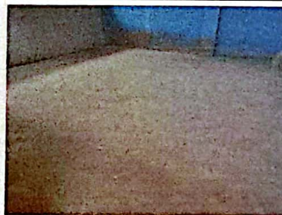
Foto 12: FOTOGRAFIA REPARACION DE PLANCHAS DE CONCRETO (0.10M)
