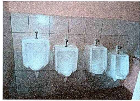
Foto 2: Sustrucción del área del baño que se encontraba en mal estado.
