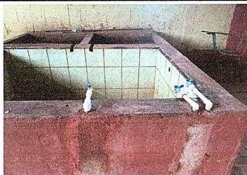
Foto 9: Mejoramiento de los grifos.
