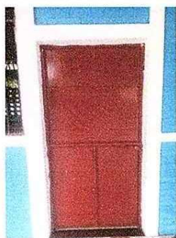
Foto 11: Mejoramiento de la puerta que estaba oxidada.
