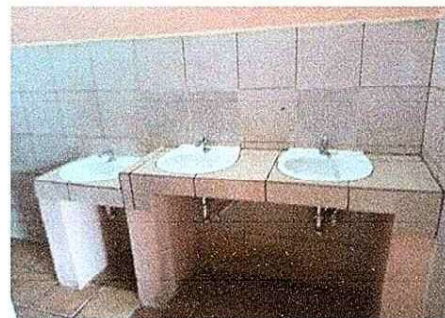
Foto 6: Instalación de un lavamos faltante.
