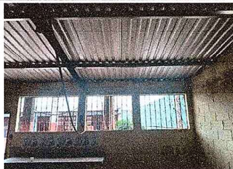
Foto 8: Cambio de las láminas deterioradas.
