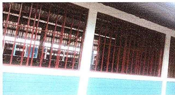
Foto 10: Mejoramiento de los balcones y pintura de las paredes.
