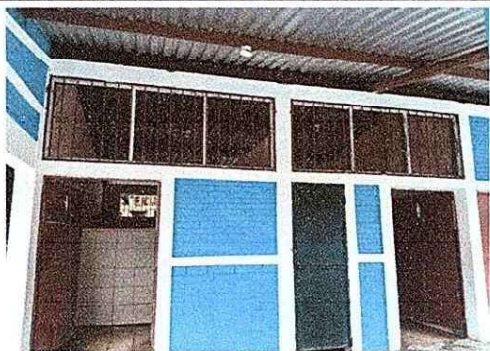
Foto 7: Colocación de balcones de metal.
