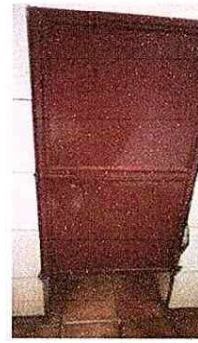
Foto 4: Mantenimiento realizado a las puertas de los baños.
