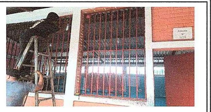
Foto 10: Pintado de balcones en mal estado
