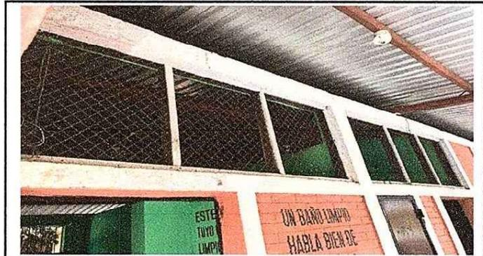
Foto7: Mejoramiento de ventanas con la implementación de balcones de metal.
