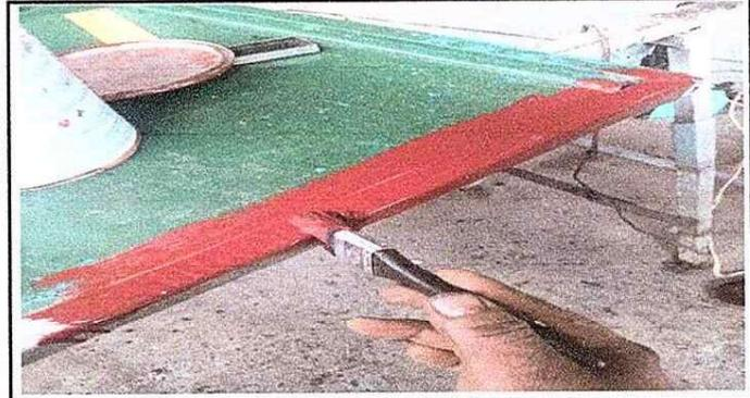
Foto 4: Se observa el mantenimiento de las puertas de los sanitarios en proceso de reparación de soldadura y pintado.
