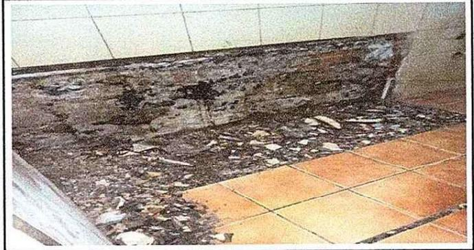
Foto 2: Se observa la demolición del migitorio antiguo.
