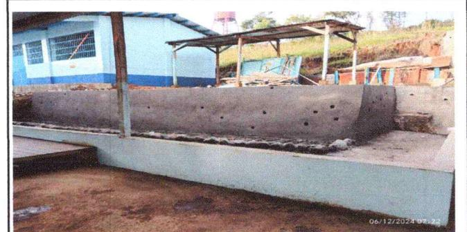
FOTO 2 SUSTITUCIÓN MURO EXISTENTE POR MURO DE CONCRETO CICLOPEO, APLICACIÓN DE SABIETA Y REPELLO
