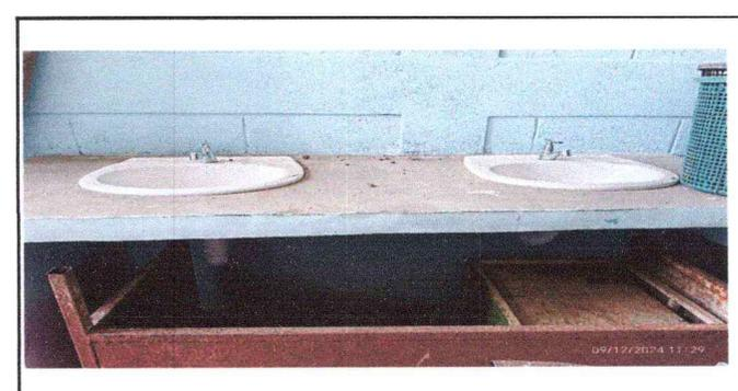
FOTO 6 REPARACIÓN DE LAVAMANOS INLCUYE CONTRALLAVE, TUBO DE ABASTO, SISTEMA HIDRAULICO Y SANITARIO EN BAÑOS DE HOMBRES Y MUJERES
