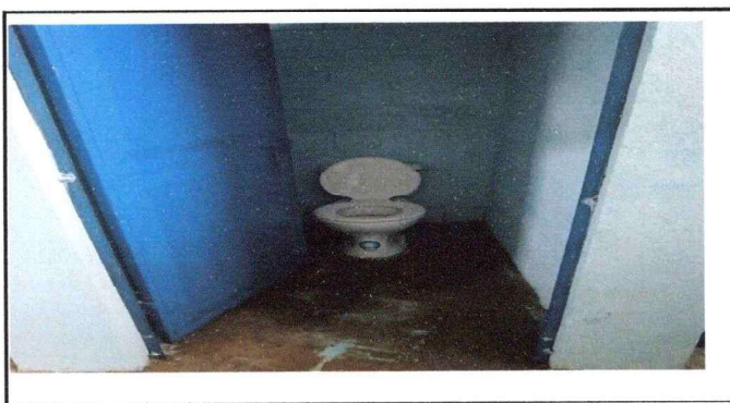
FOTO 5 SUSTITUCIÓN DE SANITARIOS O INODOROS EN BAÑOS DE MUJERES Y HOMBRES.
