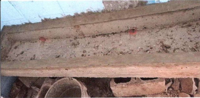
FOTO 7 REPARACION DE MINGITORIOS DE PORCELANA EN SU RED HIDRAULICA, SISTEMA SANITARIO
