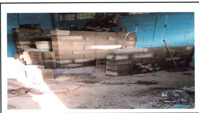
FOTO 3 SUSTITUCIÓN DE PAREDES DE TABLAYESO POR MUROS DE BLOCK
