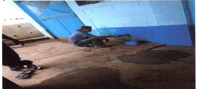
FOTO 8 RESANE Y APLICACIÓN DE PINTURA LATEX ACRILICA EN PAREDES EXTERIORES
