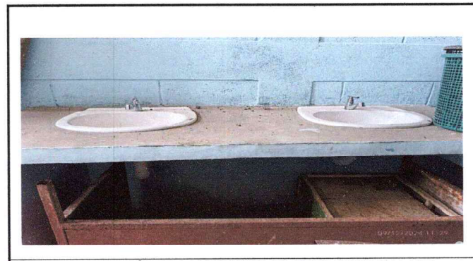
FOTO 6 REPARACIÓN DE LAVAMANOS INLCUYE CONTRALLAVE, TUBO DE ABASTO, SISTEMA HIDRAULICO Y SANITARIO EN BAÑOS DE HOMBRES Y MUJERES
