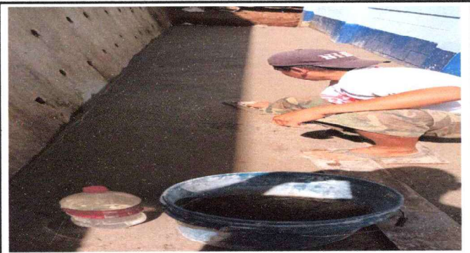
FOTO 1 REPARACIÓN DE CUNETAS DE CONCRETO
