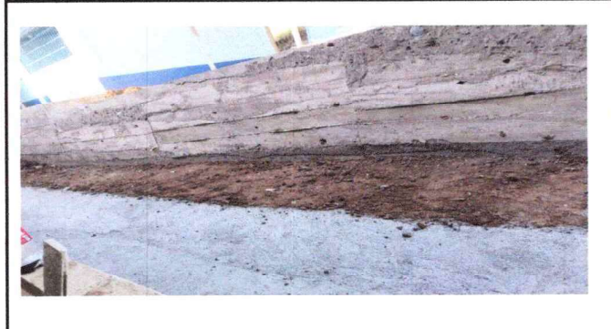
FOTO 2 SUSTITUCIÓN MURO EXISTENTE POR MURO DE CONCRETO CICLOPEO, APLICACIÓN DE SABIETA Y REPELLO
