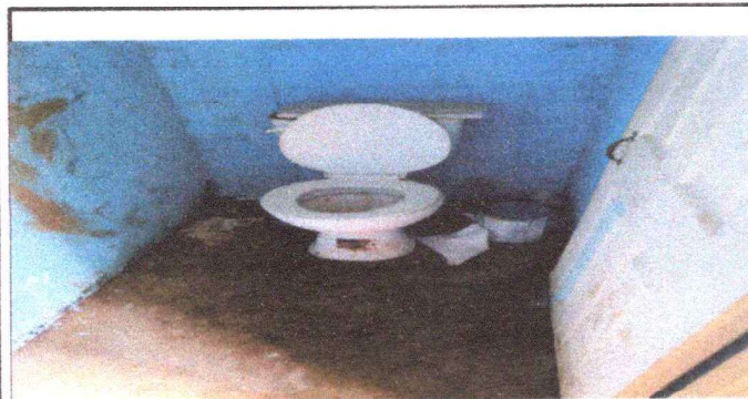
FOTO 5 SUSTITUCIÓN DE SANITARIOS O INODOROS EN BAÑOS DE MUJERES Y HOMBRES.
