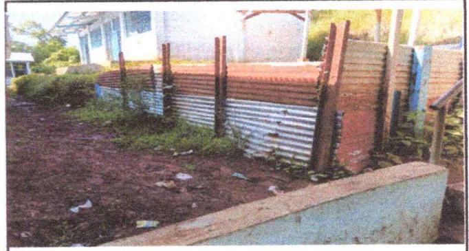
FOTO 2 SUSTITUCIÓN MURO EXISTENTE POR MURO DE CONCRETO CICLOPEO, APLICACIÓN DE SABIETA Y REPELLO
