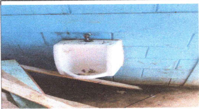
FOTO 7 REPARACION DE MINGITORIOS DE PORCELANA EN SU RED HIDRAULICA, SISTEMA SANITARIO
