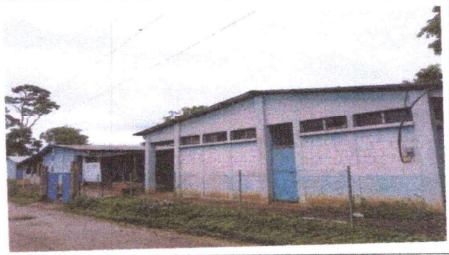
FOTO 8 RESANE Y APLICACIÓN DE PINTURA LATEX ACRILICA EN PAREDES EXTERIORES
