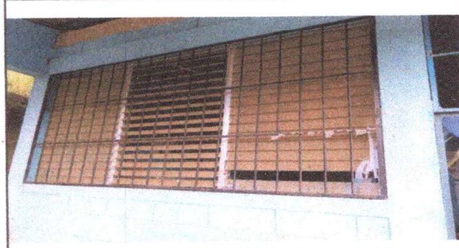
FOTO 10 MANTENIMIENTO DE BALCONES EN SALONES Y SANITARIOS LIJADO Y APLICADO DE PINTURA.
