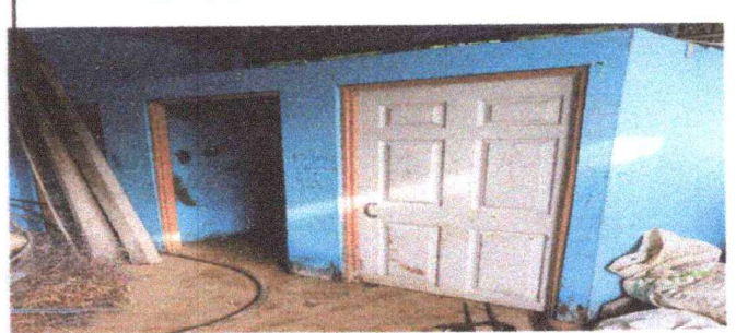
FOTO 4 SUSTITUCIÓN DE PUERTAS EN SANITARIOS.
