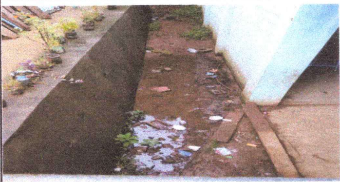
FOTO 1 REPARACIÓN DE CUNETAS DE CONCRETO
