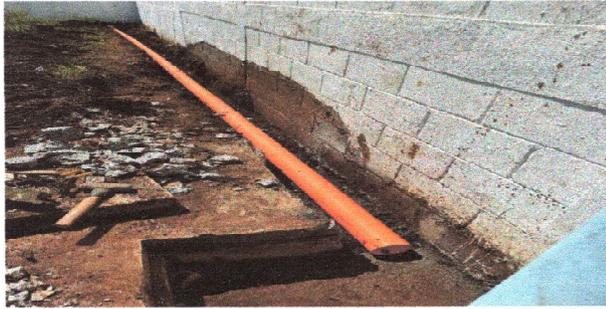
Foto 1: Se observa el proceso de drenaje de salida de agua pluvial
