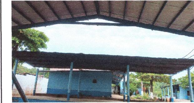
Foto 1: Se observa la necesidad de sustitución de lamina de Escenario
