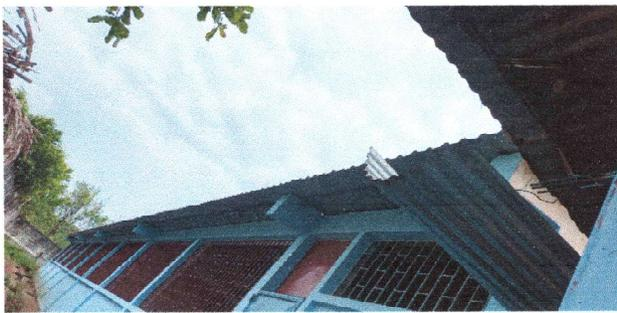
Foto 3: Se observa la necesidad canales de agua de metal y bajada de agua
