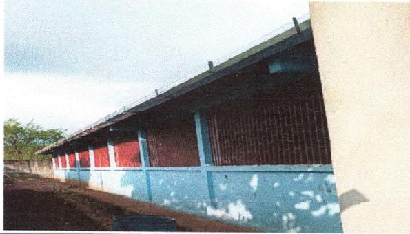
Foto 1: Se observa la necesidad implementar drenaje de agua pluvial a calle
