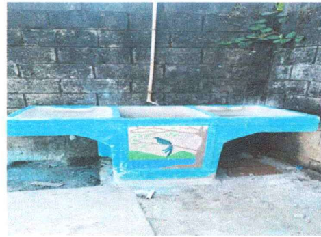
Foto 16: Sustitución de pila de cementode de 2 lavaderos.
