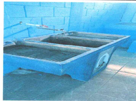
Foto 6: Sustrucción de pila de cemento de 2 lavaderos.
