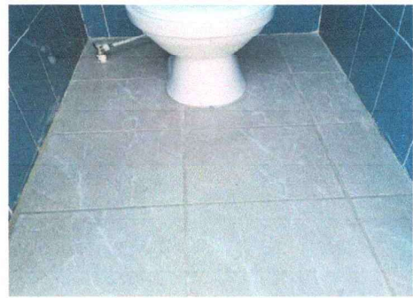
Foto 12: Suministro e instalación de piso cerámico.
