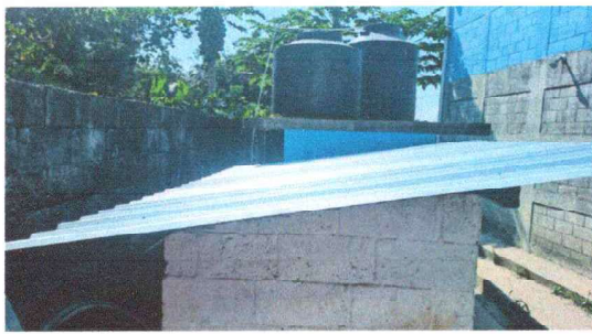
Foto 15: Sustitución de lámina por lamina troquelada aluzinc calibre 26.
