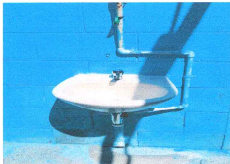
Foto 17: Sustitución de lavamanos.
