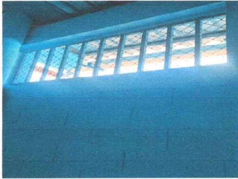
Foto 7: Mantenimiento de balcones de metal.
