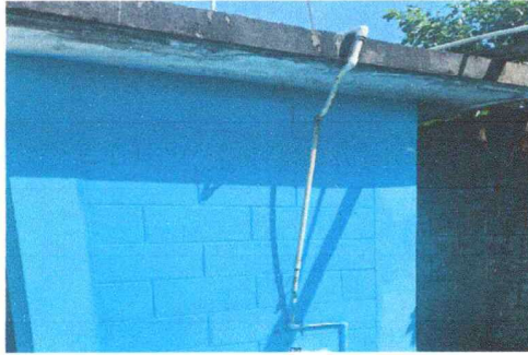
Foto 13: Resane y aplicación de pintura en muros interiores y exteriores.
