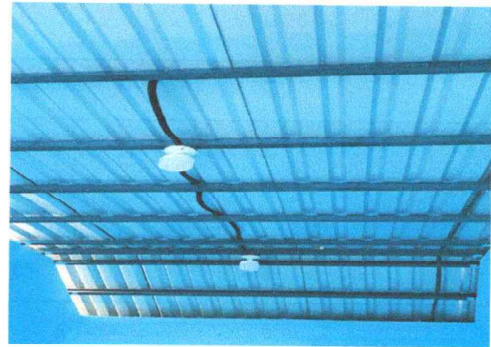
Foto 4: Sustrucción de Sistema eléctrico.
