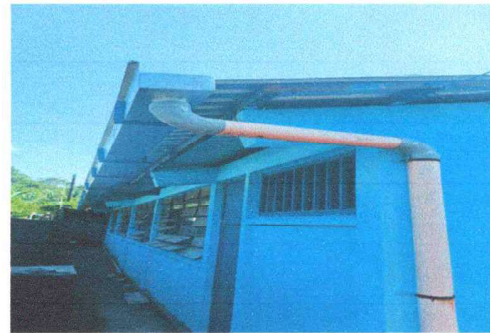
Foto 18: Sustitución de canal de metal.
