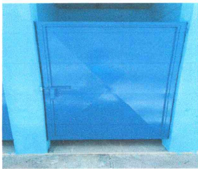
Foto 11: Sustitución de puertas de servicios sanitarios.
