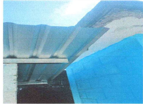
Foto 14: Sustitución de estructura de soporte de metal, por metal.
