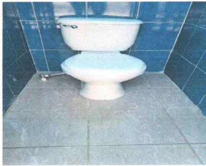
Foto 9: Sustitución de inodoro.
