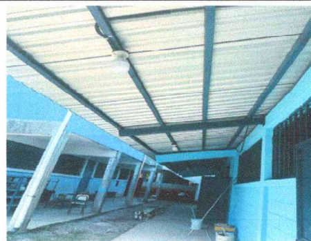
Foto 20: Sustitución de sistema Eléctrico.
