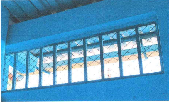
Foto 7: Mantenimiento de balcones de metal.
