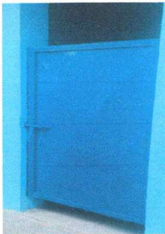
Foto 11: Sustitución de puertas de servicio sanitario.
