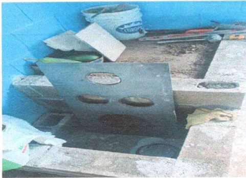
Foto 1: Sustrucción de estufa Rual.
