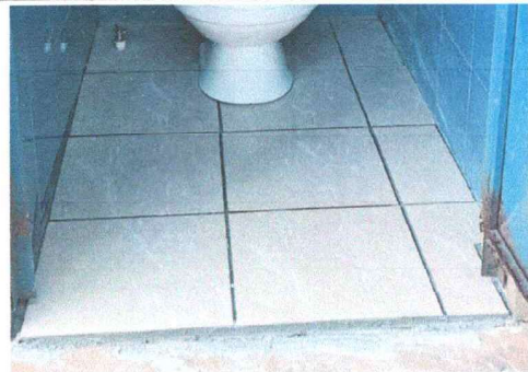
Foto 12: Suministro e instalación de piso cerámico.
