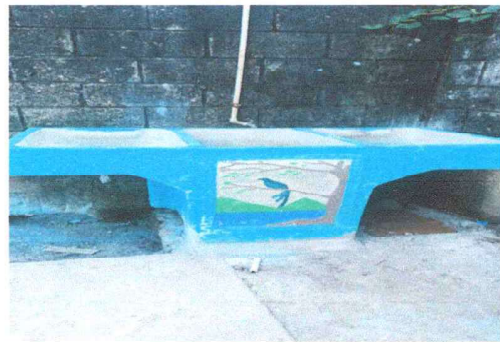
Foto 16: Sustitución Pila de cemento 2 lavaderos.
