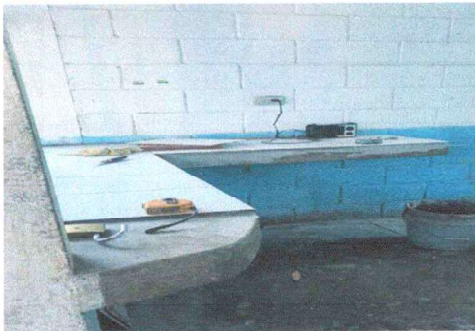
Foto 5: Instalación de azulejo en banco de trabajo.
