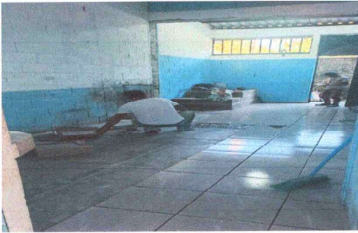
Foto 3: Sustrucción piso cerámico.
