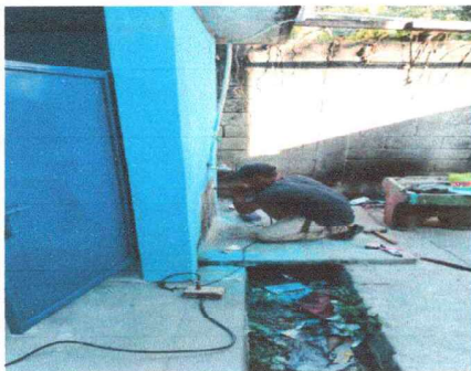
Foto 17: Sustitución de lavamanos.
