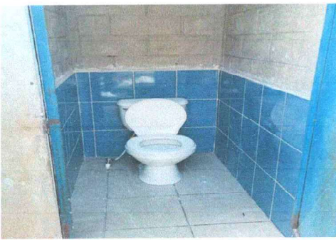
Foto 9: Sustitución de Inodoro.
