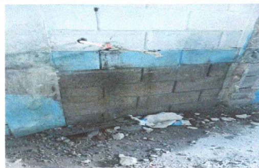
Foto 6: Sustrucción de pila de 2 lavaderos.
