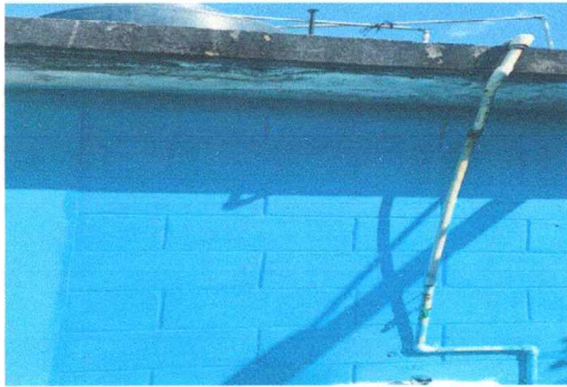
Foto 13: RESANE Y APLICACIÓN DE PINTURA.
