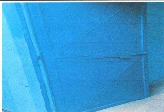
Foto 19: Mantenimiento de puertas de Metal.
