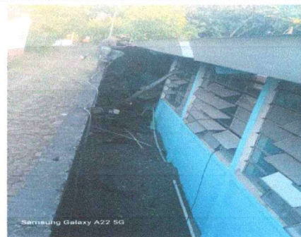
Foto 18: Sustitución de canal de metal.
