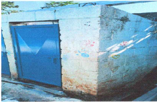
Foto 15: Sustitución de lámina.
