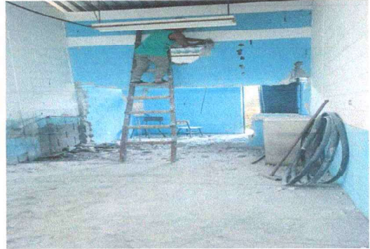
Foto 2: Mejoramiento de muro.
