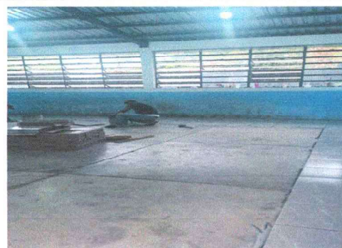
Foto 22: Suministro e instalación de piso cerámico.
