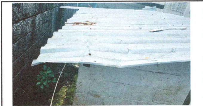
Foto 15: Se observa láminas que ya no sirven.
