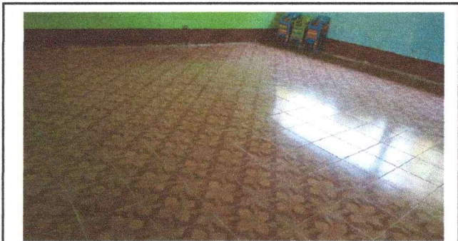
Foto 3: se observa el piso cerámico instalado.
