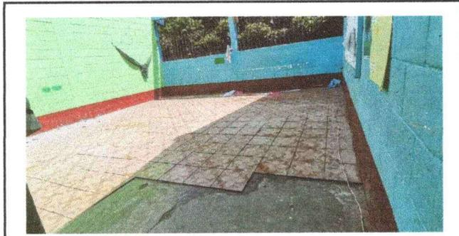
Foto 3: Se comenzó con la instalación del piso cerámico
