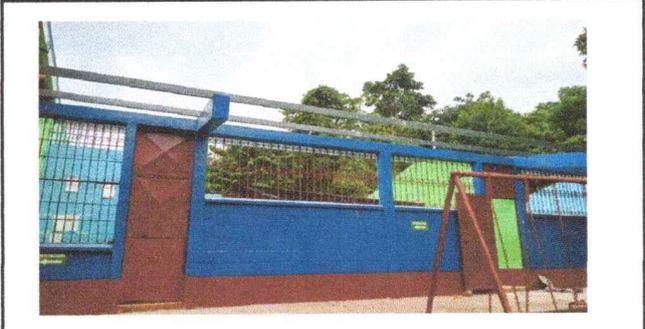
Foto 2: Se puede observar la sustitución de la estructura metálica del techo.
