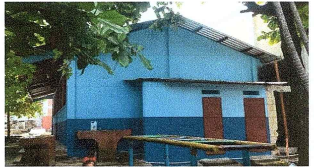
Foto 4: Mejoramiento de la parte posterior del aula.
