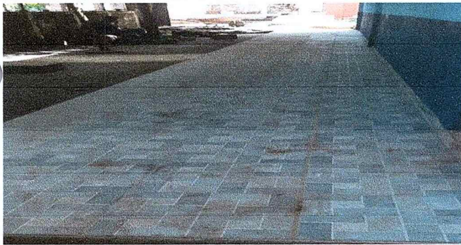
Foto 3: Mejoramiento del piso que estaba en mal estado.
