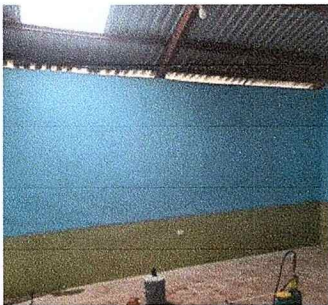
Foto 5: Repello y cernido aplicado en paredes del módulo 1.
