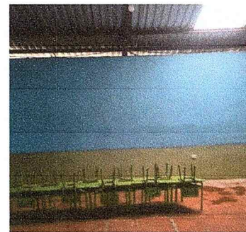
Foto 6: Repello y cernido en paredes del módulo 2.
