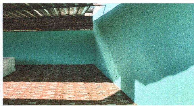
FOTO 4: Finalización en colocación de piso
