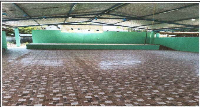
FOTO 11: Finalización de piso cerámico
