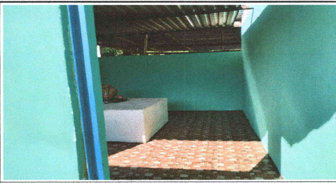
FOTO 6: Finalización de pintura en paredes
