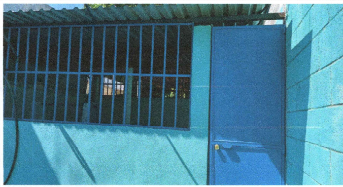
FOTO 3: Finalización de mejora en muo de cocina
