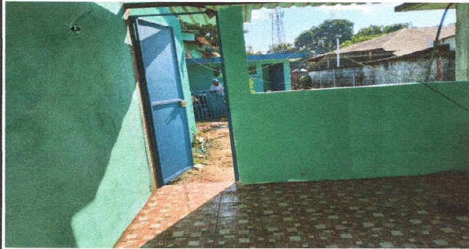
FOTO 7: Finalización de colocación de puerta en la cocina
