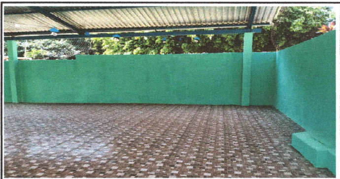
FOTO 12: Finalización de repello en muro.
