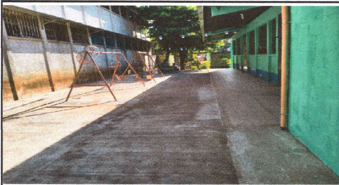
FOTO 9: Finalización de torta de concreto en patio.
