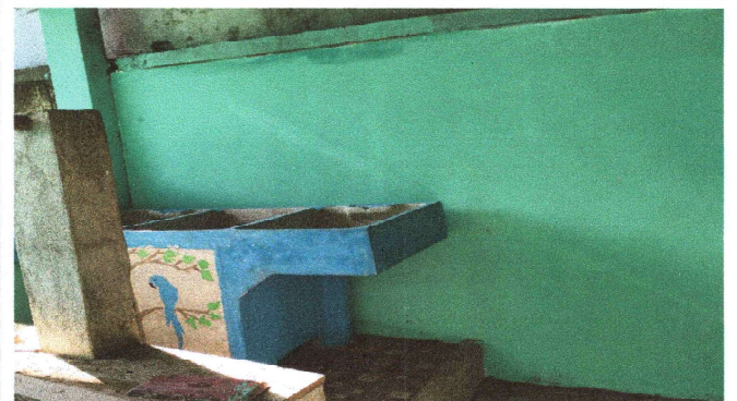
FOTO 2: Finalización de colocación de pila
