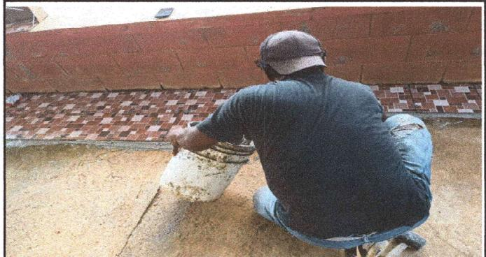
FOTO 4: Se observa el proceso de colocacion de piso ceramico.
