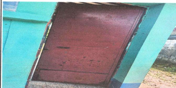
Foto 8: Se observa el mal estado de puertas.
