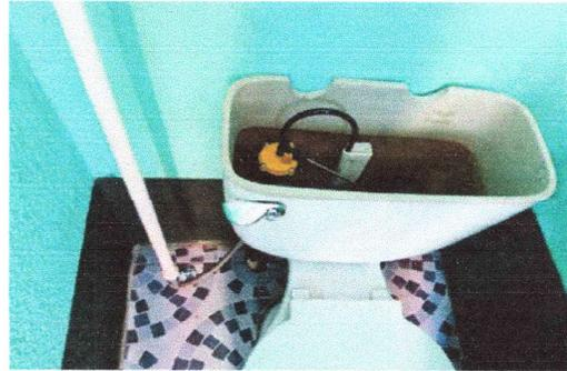
Foto 8: Finalización de cambio de accesorios de sanitario, por deterioro y fuga de agua.
