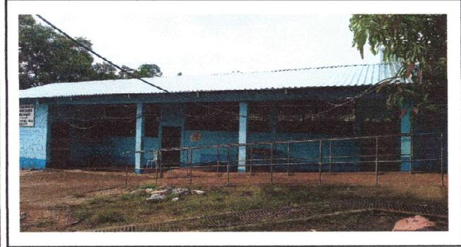
Foto 1: Finalización de colocación de lamina MaxAlum en aula
