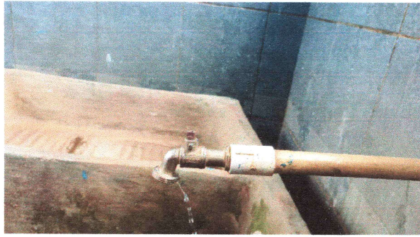
Foto 7: Sustitución de Chorros.
