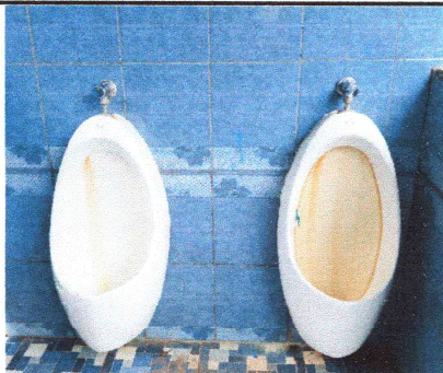
Foto 11: Mantenimiento a Mingitorios
