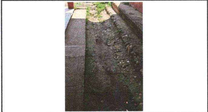
Foto 2: Se observa en mal estado la cuneta de concreto.
