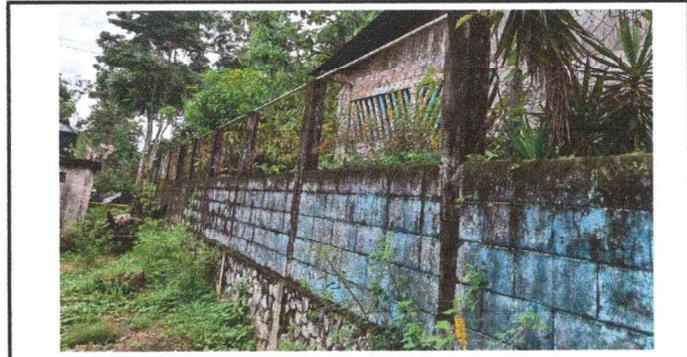
Foto 6: Se puede observar la necesidad del mantenimiento al muro con repello y pintura.
