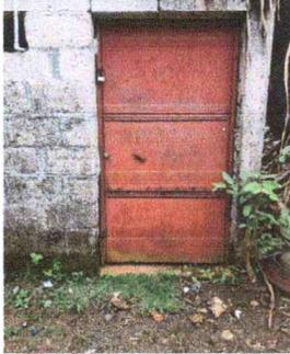
Foto 7: Se observa la necesidad de susitución de la puerta de metal.
