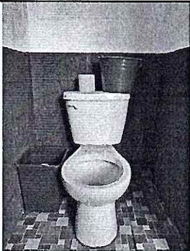
Foto 5: Se observa que inodoro necesita reparación, además muros interiores necesitan mantenimiento
