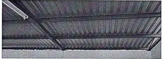
Foto 2: Se observa que aulas necesitan una protección con estructura metálica sobre la solera final, para evitar robos
