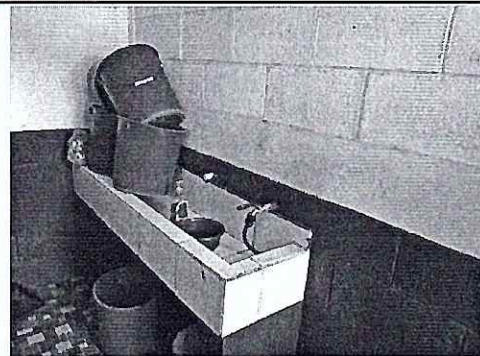
Foto 6: Se observa el lavamanos de concreto de concreto y azulejo necesita reparación. También es necesario el mantenimiento y protección de muros interiores con azulejo
