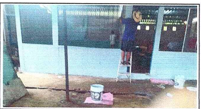
Foto 6: Se observa la aplicación de pinturas a las aulas.
