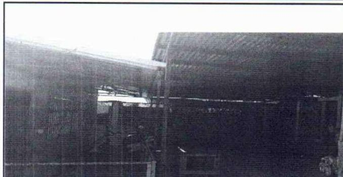
FOTO 1: SE OBSERVA ÓXIDO Y EL MAL ESTADO EN LAS LÁMINAS, URGE SUSTITUCIÓN.
