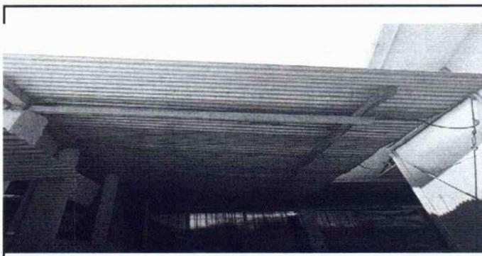
FOTO 6: SE OBSERVA FALTA DE CANAL, URGE COLOCACIÓN PARA A BAJADA DE AGUA.
