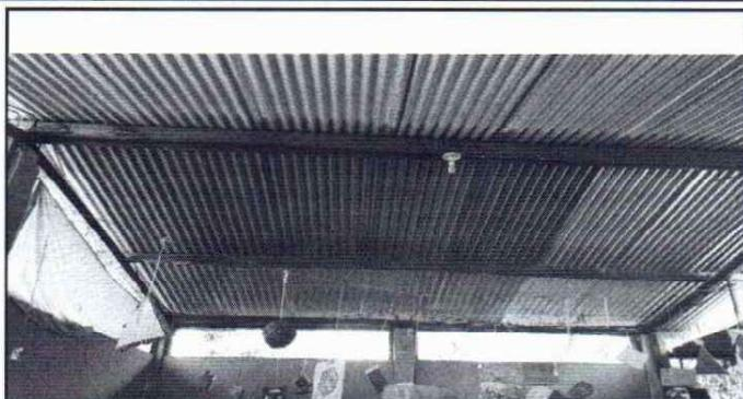
FOTO 2: SE OBSERVA EL MAL ESTADO DE LAS ESTRUCTURAS PORTANTES DE MADERA.
