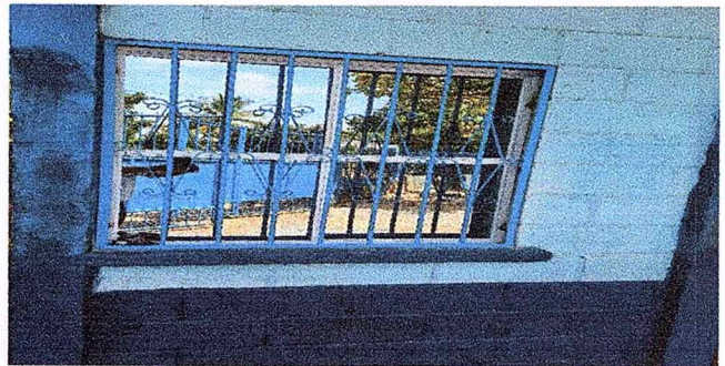
Foto 4: SE OBSERVA QUE SE INSTALO VENTANA NUEVA
