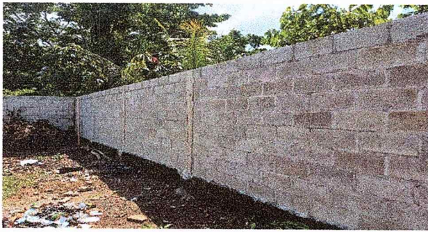
Foto1: SE OBSERVA QUE YA SE FINALIZO EL MURO PERIMETRAL.
