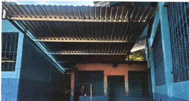
Foto 7: Se puede observar la sustitución de la lámina troquelada.
