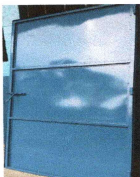
Foto 3: Se puede observar la puerta que se sustituirá.
