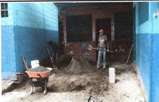
Foto 5: Inicio de de sustitución de torta de concreto.
