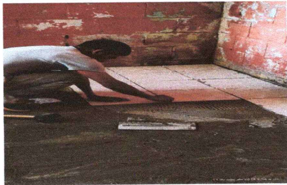
Foto 1: Se observa la colocación del piso cerámico.
