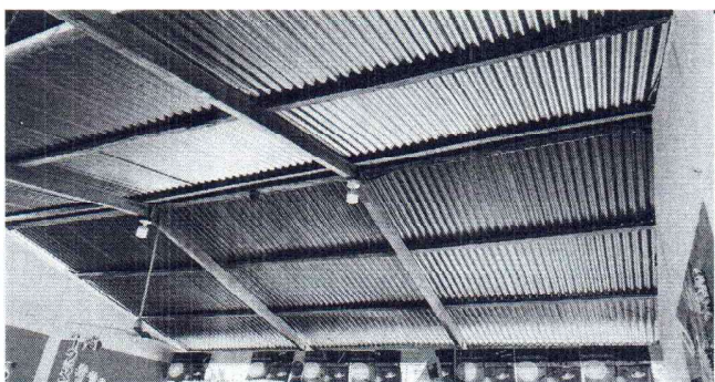
Foto 5: Se observa que es necesario cambiar el techado y cambiar la estructura de madera a metal.
