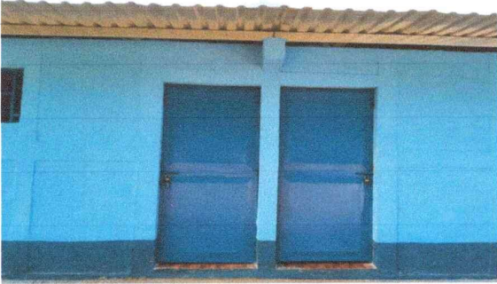
Foto 7: Se colocaron nuevas puertas externas.
