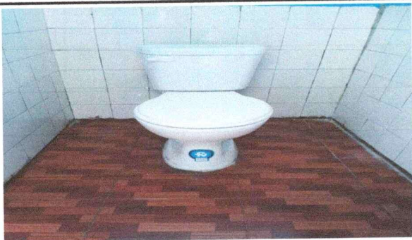
Foto 5: Se colocaron sanitarios nuevos.
