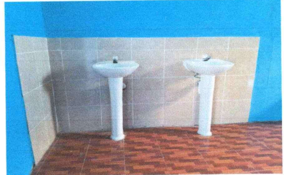
Foto 4: Se colocaron lavamanos nuevos.
