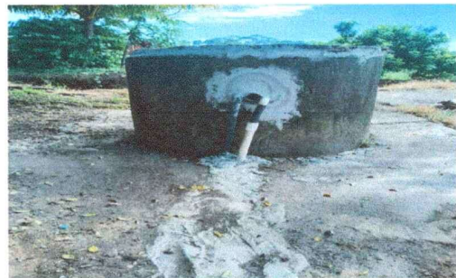
Foto 12: Se instalo una bomba de agua.
