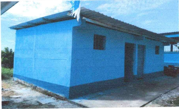
Foto 1: Las paredes de los sanitarios quedaron en perfectas condiciones.
