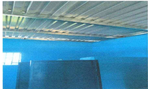
Foto 10: Se cambio toda estructura de soporte del techo de los sanitarios.
