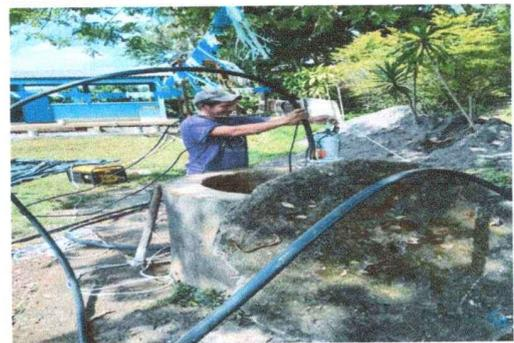
Foto 12: Se esta instalando la bomba de agua.
