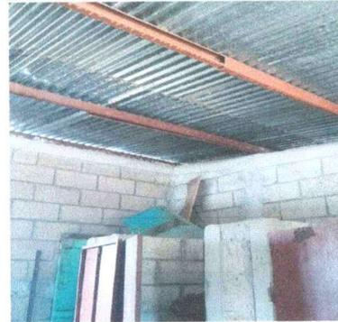
Foto 10: La estructura de soporte del techo de los sanitarios está en mal estado.
