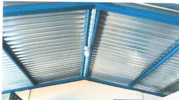
Foto 2: Se observa el cambio de la estructura metálica.
