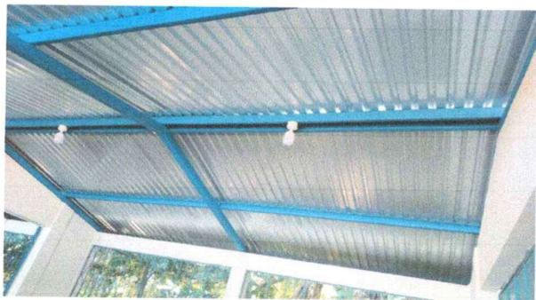
Foto 1: Se observa las láminas en buen estado.
