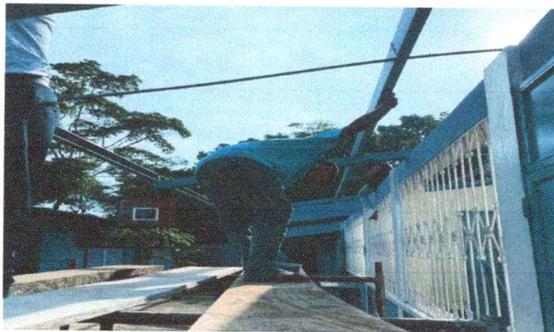
Foto 8: Se observa el mantenimiento de costaneras.
