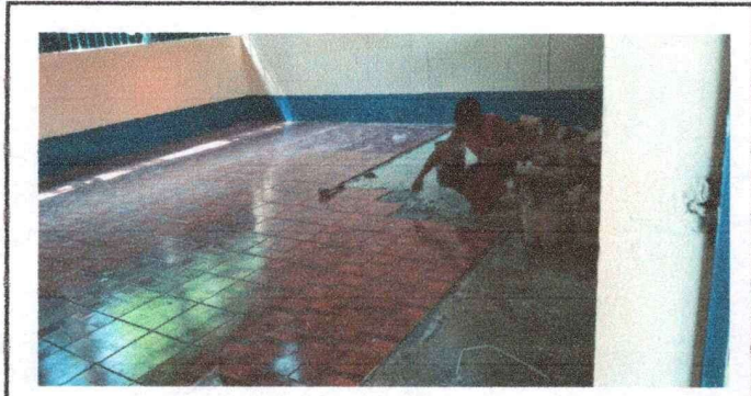
Foto 1: Se observa pegado de piso ceramico en aulas
