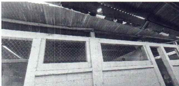
Foto 5: Se observa sustitución de canal y repello de aulas.
