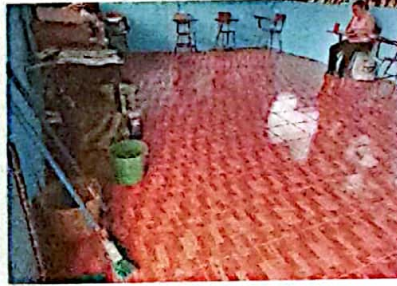
Foto 4: FOTOGRAFIA SUMINISTRO E INSTALACION DE PISO EN EL AULA
