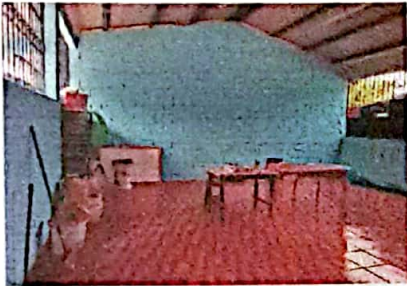
Foto 3: FOTOGRAFIA SUMINISTRO E INSTALACION DE PISO EN EL AULA
