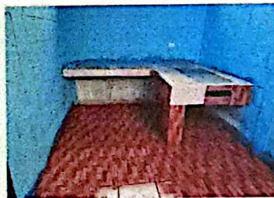
Foto 6: FOTOGRAFIA SUMINISTRO E INSTALACION DE PISO EN LA COCINA
