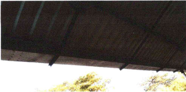
Foto 11: Se observa los canales de metal instalados.
