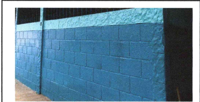
Foto 13: Se observa la pintura aplicada en las paredes.
