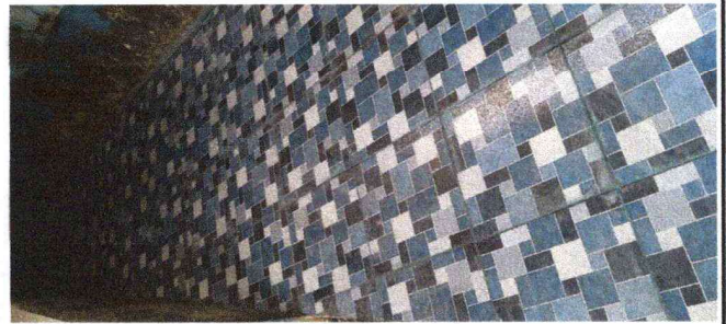
Foto 10: Se observa el piso antideslizante colocado.
