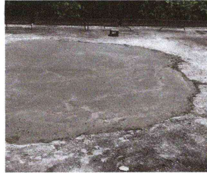
Foto 8: Se observa el mejoramiento de la terraza.
