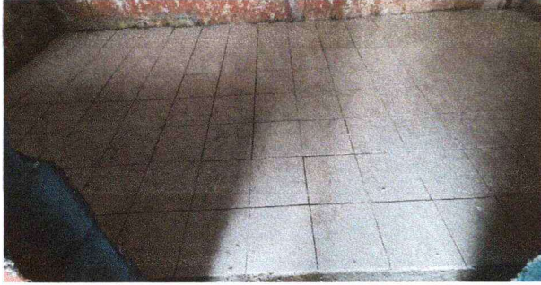
Foto 7: Se observa el proceso de mejoramiento de la torta de concreto.
