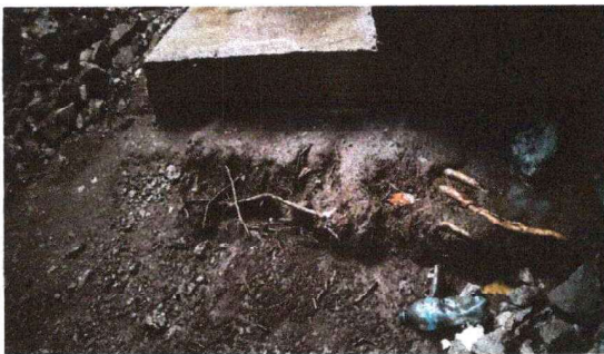
Foto 5: Inicio de reparación de la banqueta.
