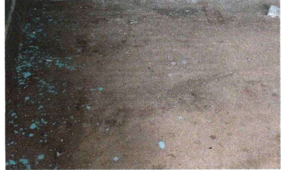
Foto 8: Se observa el inicio del mejoramiento de la terraza.
