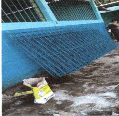
Foto 1: Se puede observar el inicio del cambio del balcones.
