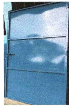
Foto 4: Se observa el mantenimiento a las puertas.
