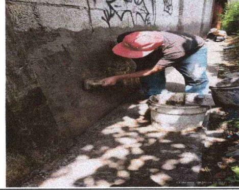
Foto 2: Se observa el repello que se está realizando.
