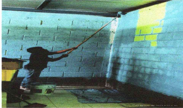
Foto 13: Se observa la aplicación de pintura en paredes.
