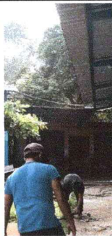
Foto 11: Se observa el proceso para la colocación de canales.
