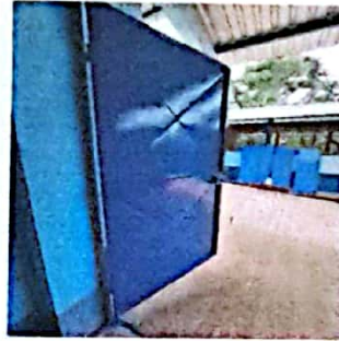
Foto 8: FOTOGRAFIA REMOZAMIENTO DE PUERTA
