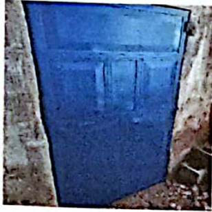
Foto 7: FOTOGRAFIA SUMINISTRO E INSTALACION DE PUERTA
