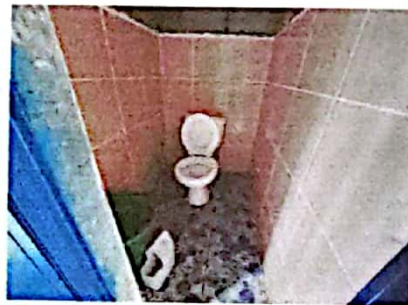
Foto 10: FOTOGRAFIA SUMINISTRO E INSTALACION DE AZULEJO, PISO
