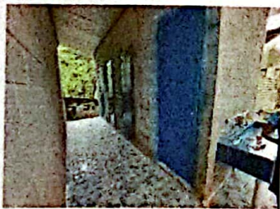
Foto 11: FOTOGRAFIA SUMINISTRO E INSTALACION DE PUERTAS
