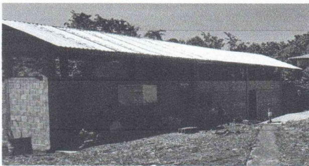
Foto 5: Es necesario la aplicación de repello en muro.
