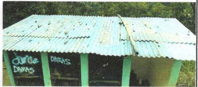
Foto 14: Se observa la necesidad de sustituir la lamina existente.
