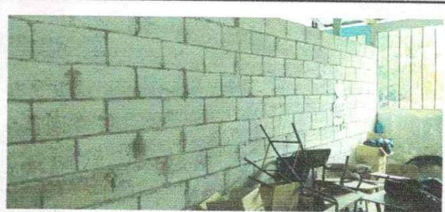
Foto 2: Se observa la necesidad de aplicar repello en los muros
