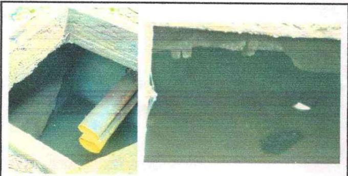
Foto 3: Se observa el mal estado que se encuentra la fosa septica
