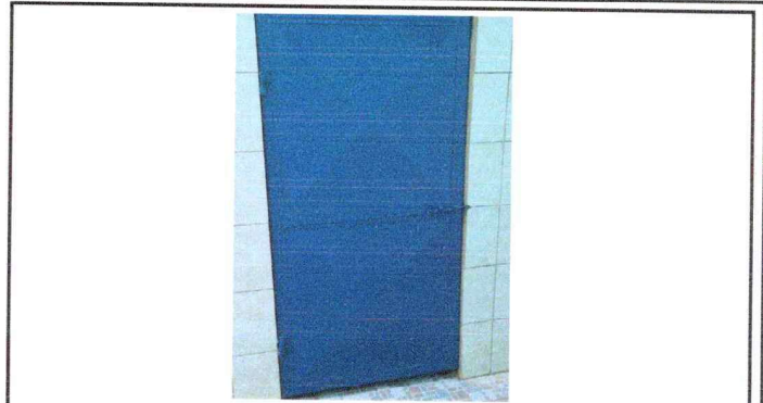
Foto 8: Culminación del mantenimiento de estructura a puertas lijadas y pintadas de los servicios sanitarios.
