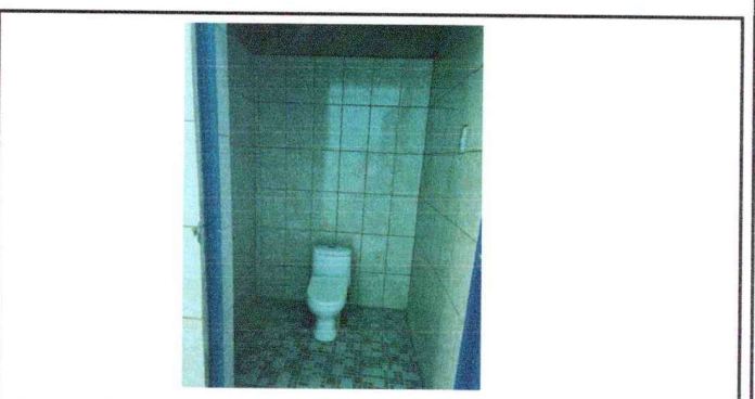
Foto 6: Terminación del suministro de azulejo colocado en los baños .
