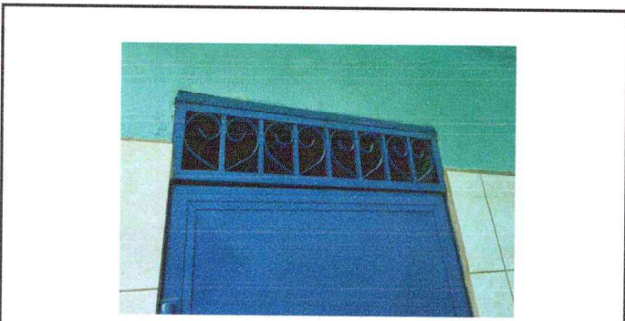
Foto 9: Finalización de la colocación de balcones de metal.
