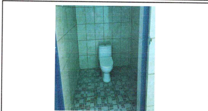
Foto 7: Terminación del suministro de piso cerámico en los baños del centro educativo.
