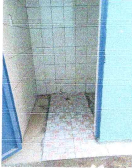
Foto 7: Colocación de suministro de piso cerámico en los baños.
