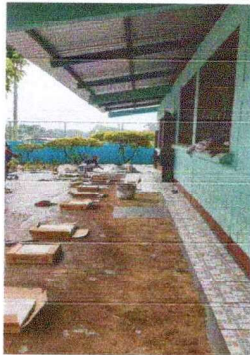
Foto 3: Colocación del piso cerámico en el corredor.
